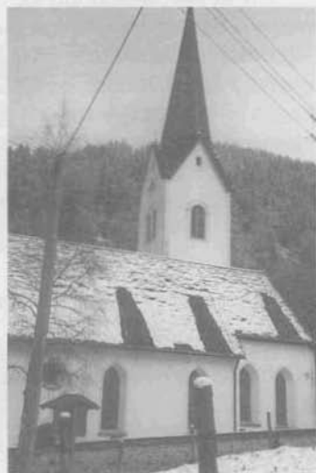
Pfarrkirche in Tiefenbach Gde. Oberstdorf
